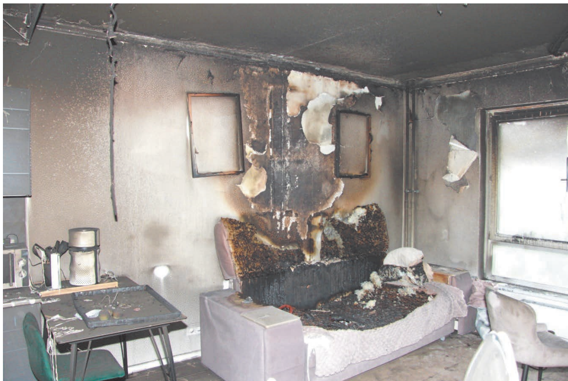
Рис. 8. Обстановка в жилой комнате на момент ее осмотра экспертом РФЦСЭ Fig. 8. Scene in the living room at the time of its inspection by the RFCFS expert
