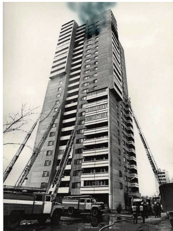
Фото. Общий вид дома № 31 на проспекте Маршала Жукова в Москве во время пожара Photo. General view of house No. 31 on Marshal Zhukov Avenue in Moscow during the fire
